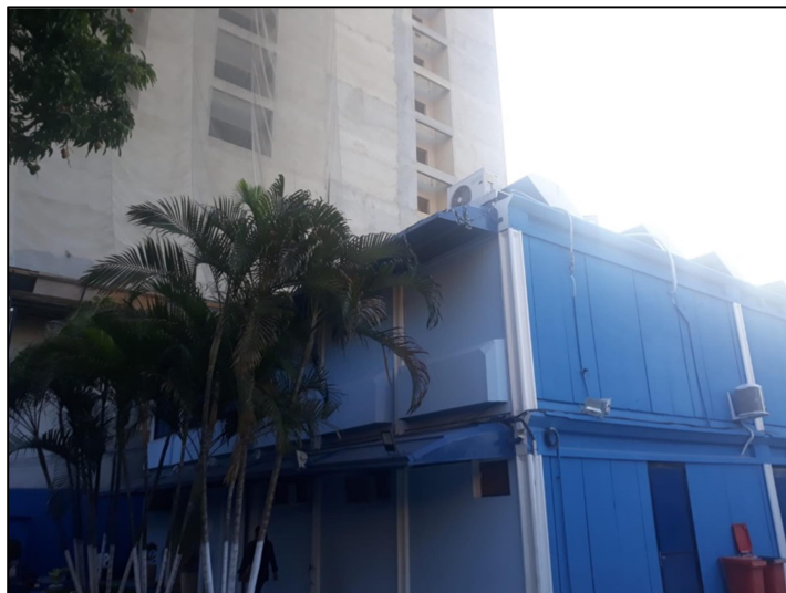
Fachada do prédio existente
