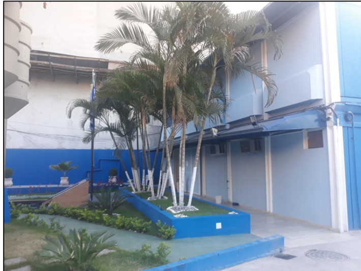
Fachada do prédio existente
